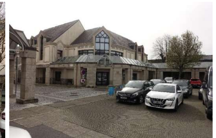
4 - Site de la future médiathèque
